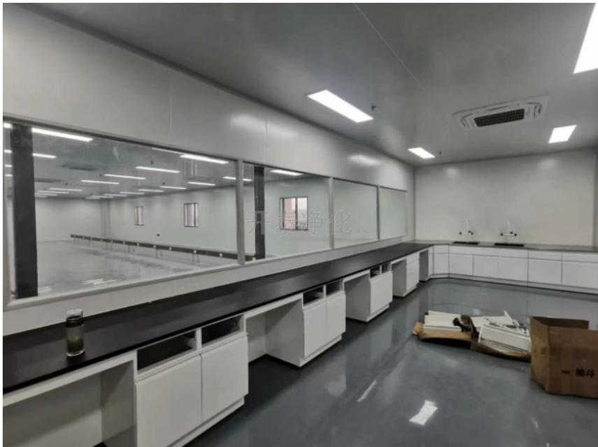
无尘车间结构材料：1. 净化厂房墙、顶板材一般多采用50mm厚的夹芯彩钢板制造，其特点为美观、刚性强、保温性能好、易施工。圆弧墙角、门、窗框等一般采用氧化铝型材制造2. 地面可采用环氧自流坪地坪或高级耐磨塑料地板，有防静电要求的可选用防静电型。3. 送回风管道用热镀锌板制成，贴净化保温效果好的阻燃型PF发泡塑胶板。4. 高效送风口用不锈钢框架，美观清洁，冲孔网板用烤漆铝板不锈钢板。
